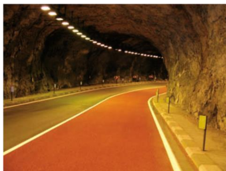
Accessos al segon túnel de la presa de Camarasa; i es situa en el PK 47+000 de la C-13
