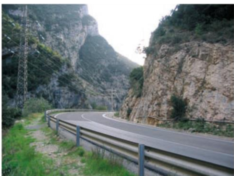
Sortida en direcció a Balaguer del túnel dels Terradets; es situa en el PK71+500 de la C-13
