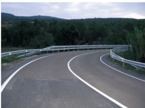
Accessos al Pont de Santa Engracia; es situa en el PK 89+200 de la carretera C-13
