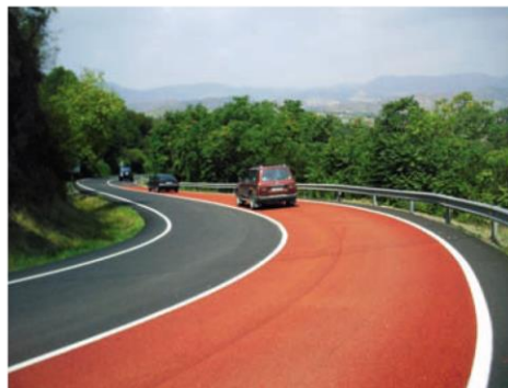
Entrada a la població de Tremp; es situa en el PK 85+500 de la carretera C-13
