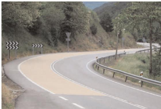
Quan el sistema antilliscant sigui de color, l'àrid estarà fabricat a partir de bauxita calcinada i posteriorment tenyida amb una resina pigmentada, que tindrà el mateix color de l'àrid. No s'usaran pintures.
