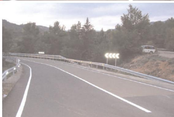
Exemples de tractament de superfícies d'alta adherència a les carreteres catalanes. Consisteix a aplicar sobre el paviment una resina de poliuretà i a sobre un àrid. S'estén en fred. Aquests regs poden disminuir el nombre d'accidents, o si més no reduir la velocitat de l'impacte, ja que aquest tipus de superfícies ofereixen un coeficient de fricció transversal (CRT) elevat que permet reduir les distàncies de frenada.
